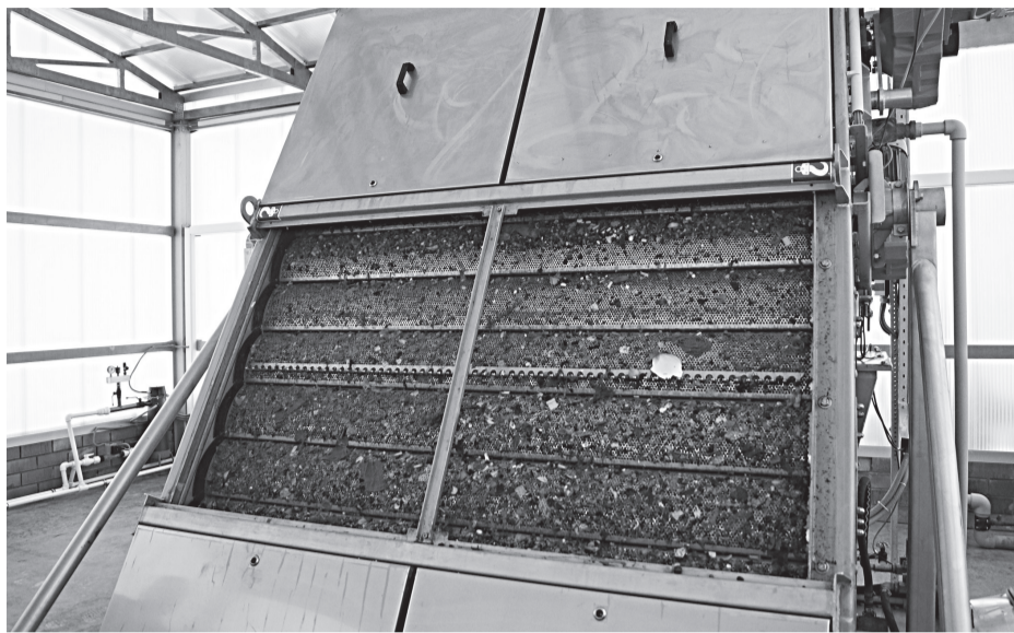
Эффективность механической очистки стоков Дзержинский водоканал увеличил с помощью вот такой решетки с перфорированными пластинами, которую на предприятии внедрили в 2016 году
