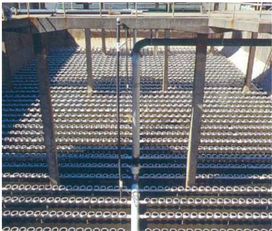
Пример установки аэрационных систем с аэраторами Sanitaire SSII
