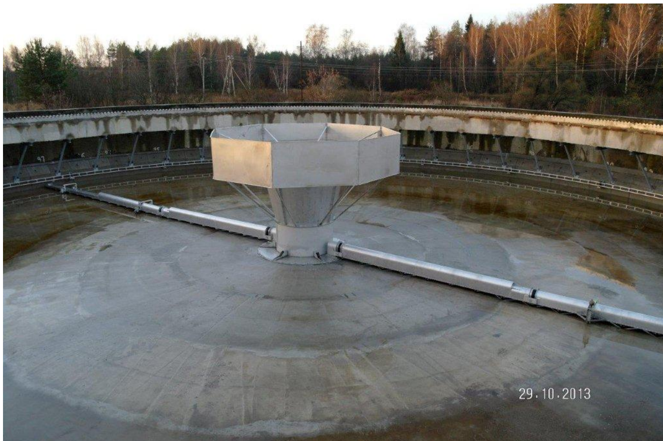
Пример установки скребковый вращающийся механизм для удаления донного осадка (ила) ZICKERT Z3700S
